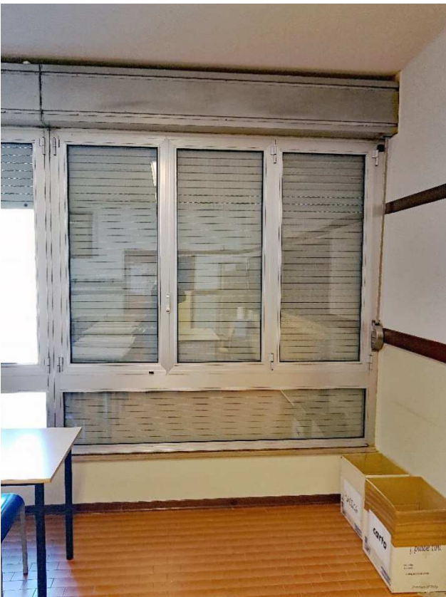
Foto prima dell'intervento
