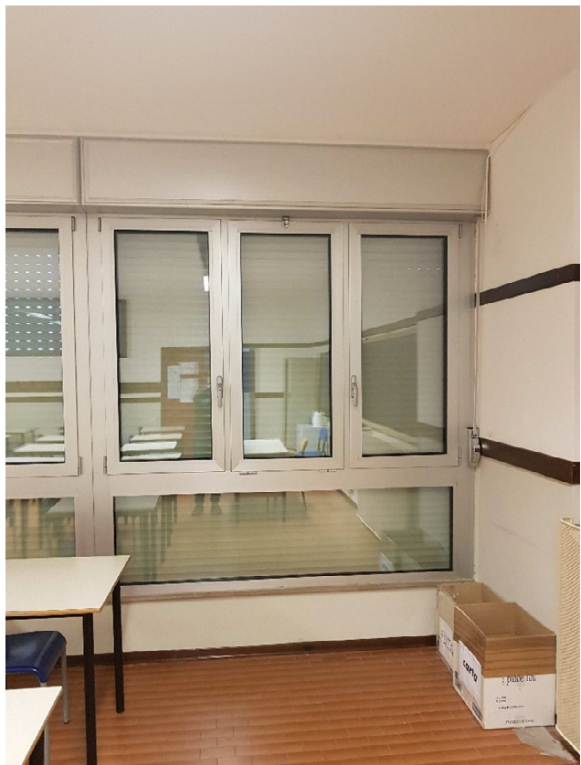
Foto dopo dell'intervento
