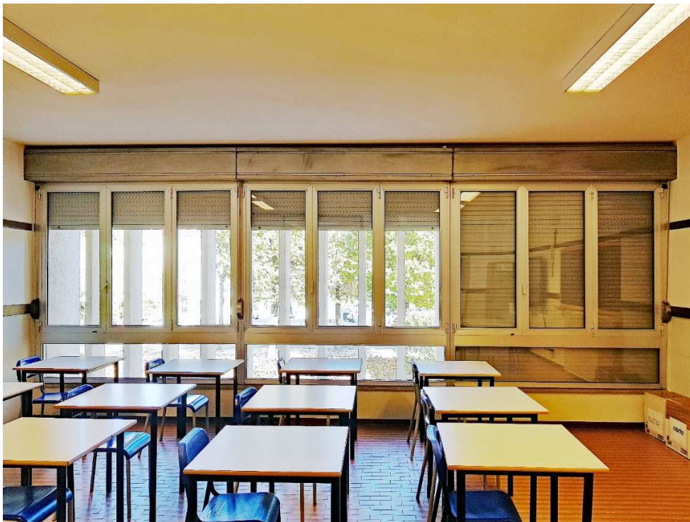
Foto prima dell'intervento
